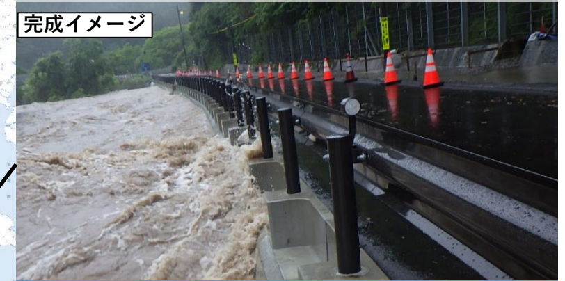
主要地方道 伊勢南島線 道路改良事業 (度会町)
