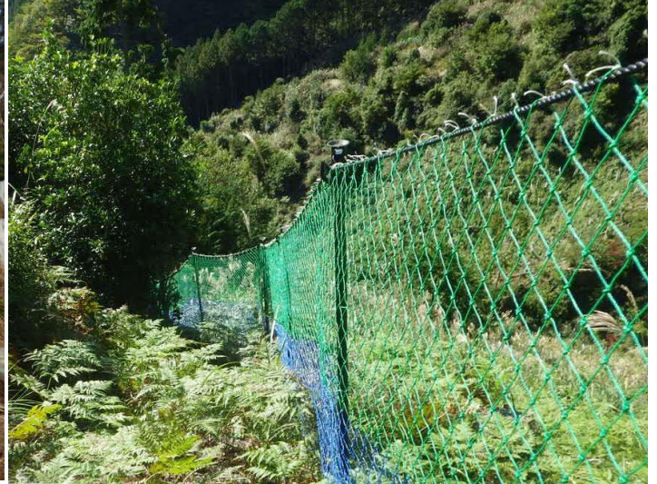
獣害防止施設設置状況
