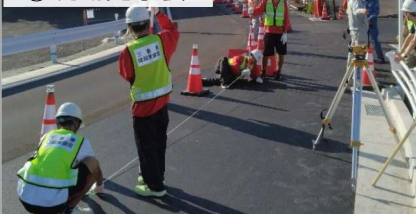
建設現場で、実際の仕事を体験
