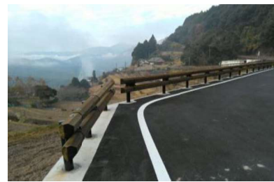
【三重県】木製ガードレール設置 (主)熊野矢ノ川線:熊野市内
