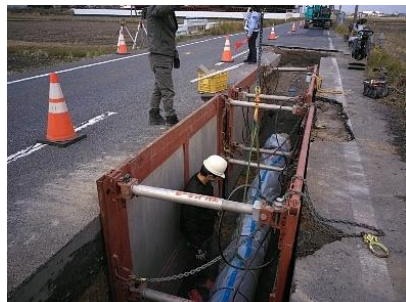
送水管布設替工事の施工例
