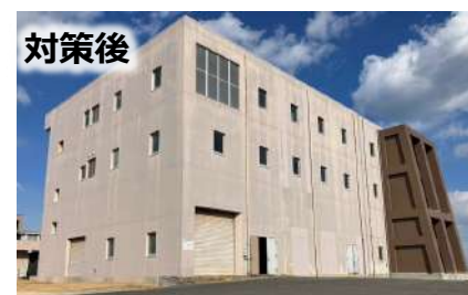
耐震補強壁を追加した汚泥処理棟
