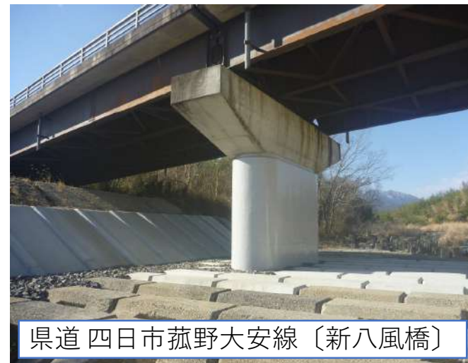
橋梁耐震対策事業
