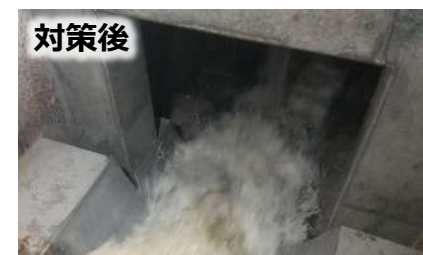
柱補強を実施したマンホール内部の様子
