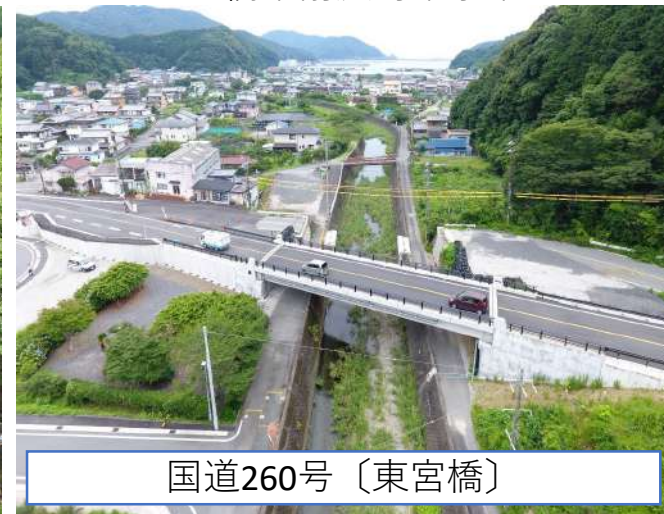
橋梁耐震対策事業
