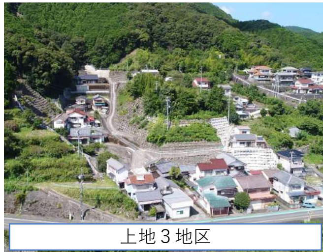
急傾斜地崩壊対策事業
