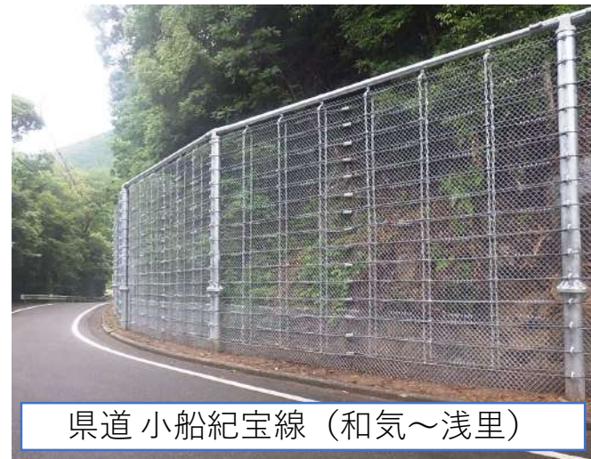
土砂災害対策道路事業
