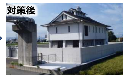
ポンプ場外周に防潮壁を整備
