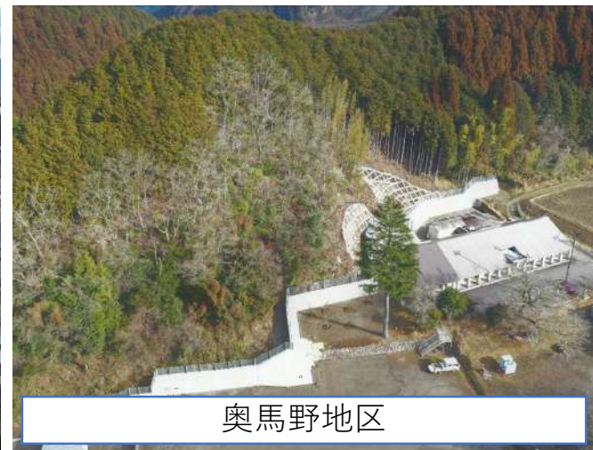
急傾斜地崩壊対策事業
