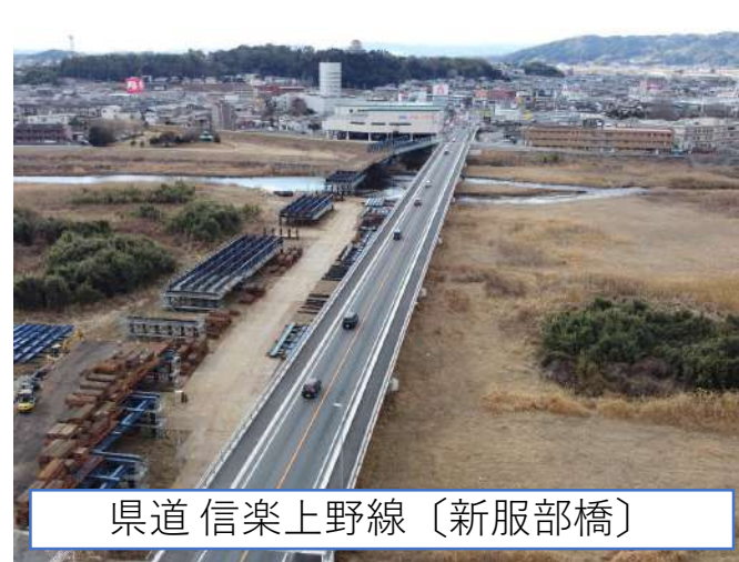
橋梁耐震対策事業
