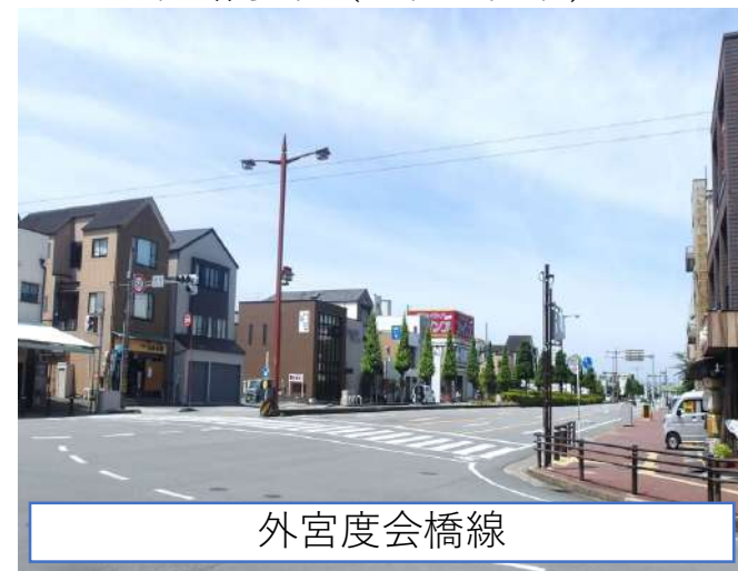
街路事業 (電線共同溝)
