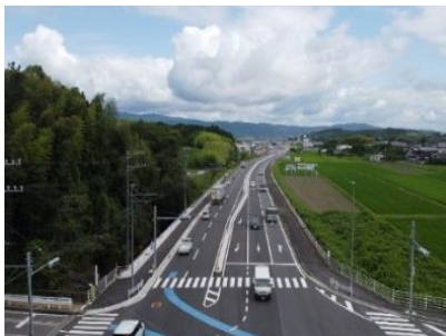
道路改良事業（拡幅）
