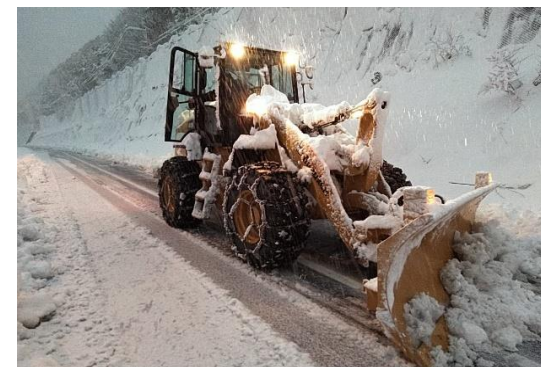
道路の除雪作業 (いなべ市)
