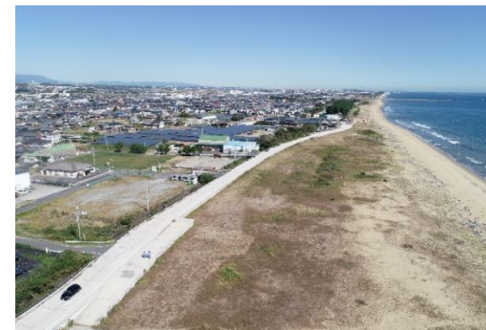
上野地区海岸高潮対策事業 (津市)
