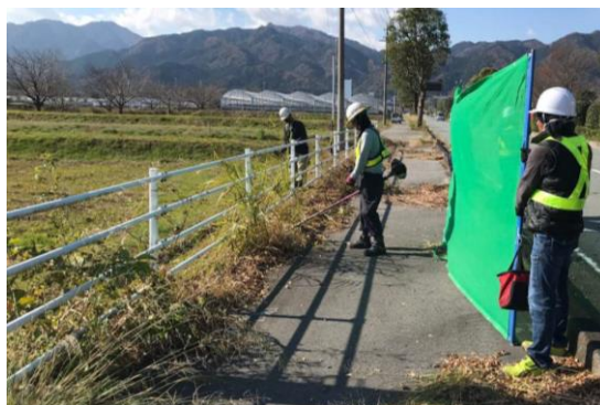
道路の除草作業 (松阪市)
