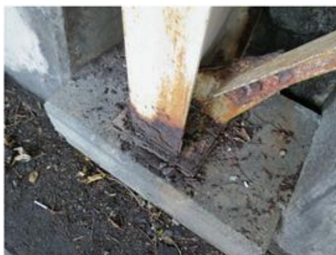
柱の腐食
