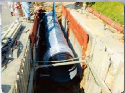
配水管布設替工事の施工状況
