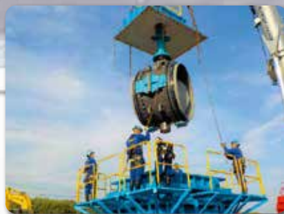
制水弁取替工事の施工状況
