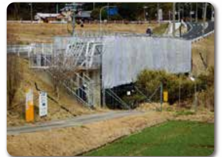
塗装塗替中の水管橋
