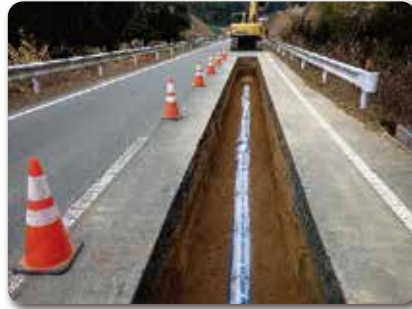
耐震管への布設替え
