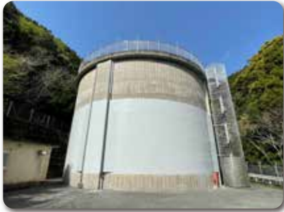
調整池の耐震補強
