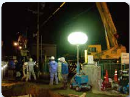
夜間の漏水復旧作業
