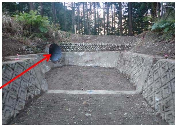
土砂撤去により、暗渠と流路の閉塞が解消され、水が流れる幅や高さを確保できた。
