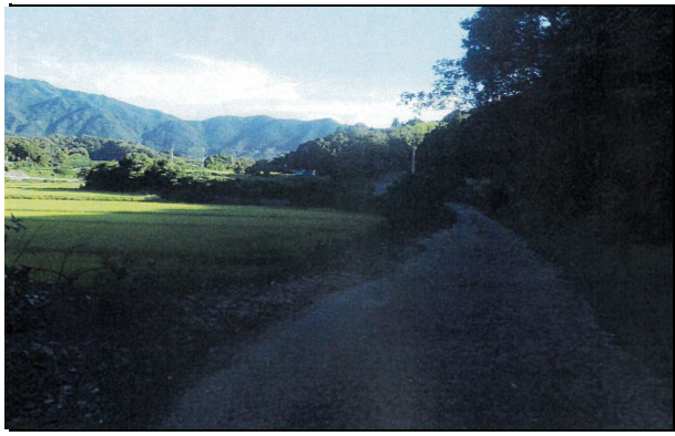
写真6 大田丸塚線（完成）
