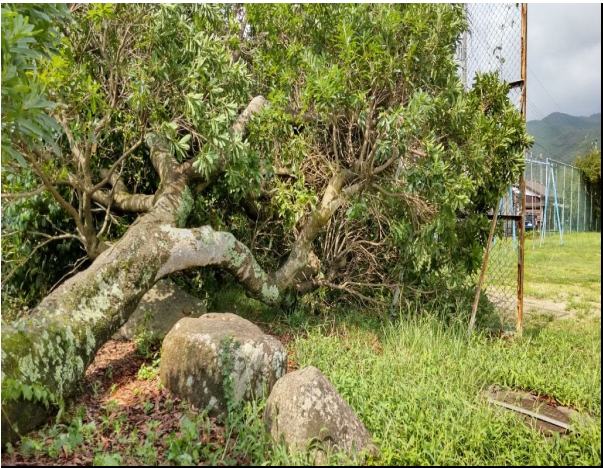
写真1 危険木伐採（有馬小学校）施工前
