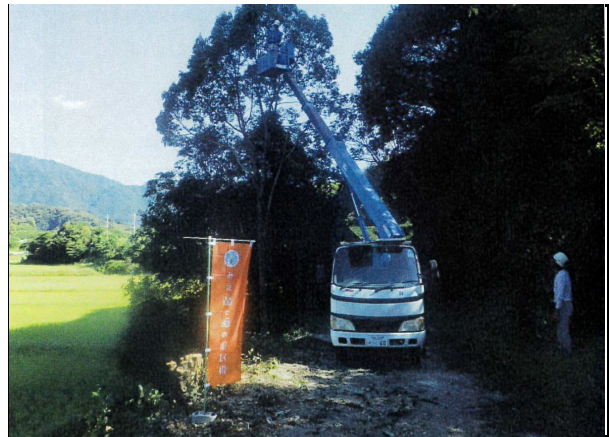
写真4 大田丸塚線（伐採状況）
