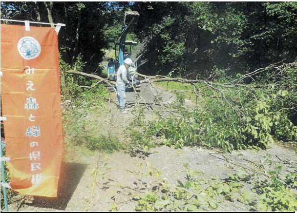
写真3 大田丸塚線（伐採状況）
