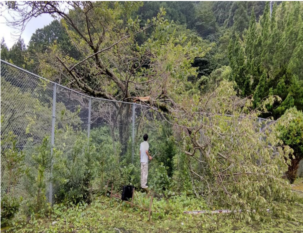
写真3 危険木伐採（荒坂中学校）施工前
