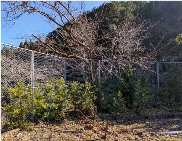
写真4 危険木伐採（荒坂中学校）施工後
