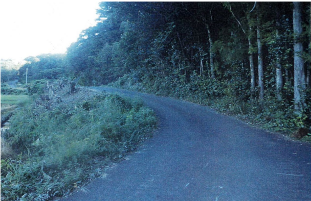
写真5 大田丸塚線（完成）
