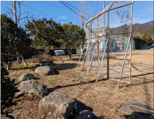
写真2 危険木伐採（有馬小学校学校）施工後
