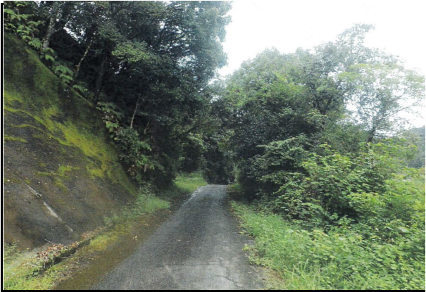
写真1 大田丸塚線（着工前）
