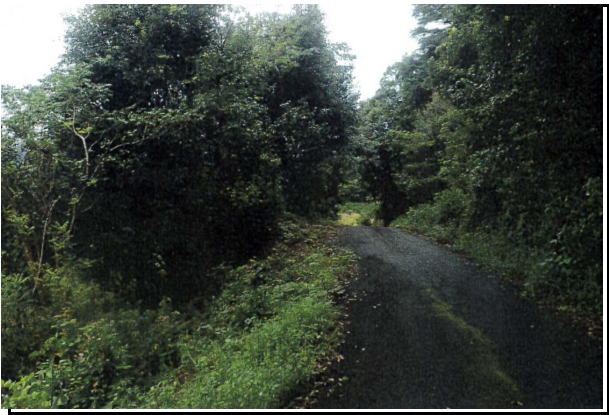
写真2 大田丸塚線（着工前）
