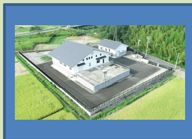
(農業集落排水施設)
