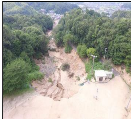
上流側から撮影
