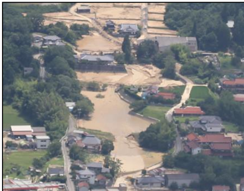
下流側から撮影
