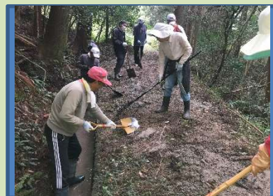
(水路の泥上げ)
