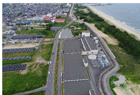
志登茂川浄化センター
