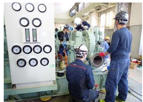
下水処理設備の点検状況
