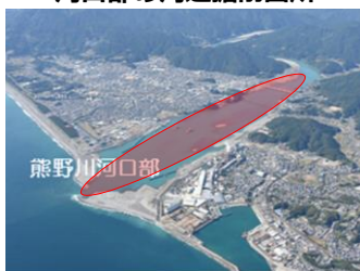
河口部の河道掘削箇所
