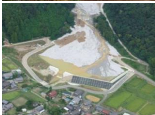
土石流 補足後
