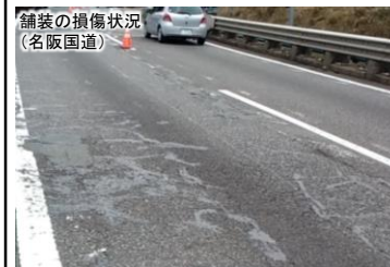
舗装の損傷状況(名阪国道)
