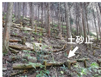
伐倒木を利用した土砂止の設置
