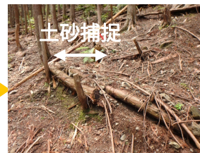
土砂捕捉 土砂止の土砂捕捉量などの多点調査
