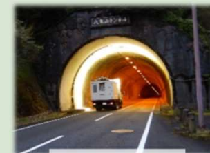
トンネルの点検
