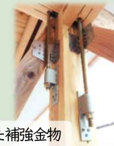
土台・柱部分に設置された補強金物
