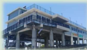
津波避難施設
