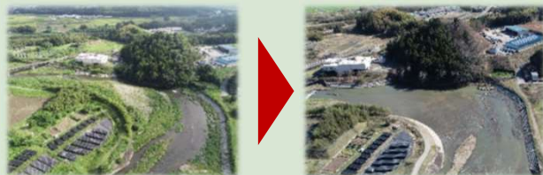
河川の堆積土砂撤去（長野川（津市））
