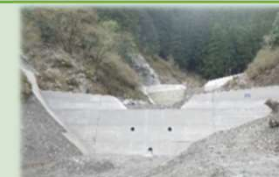
治山ダムの整備（松阪市）
