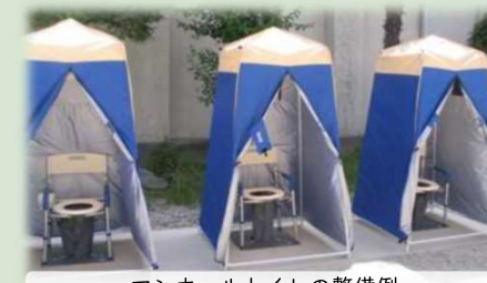
マンホールトイレの整備例
