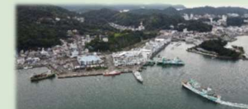
鳥羽港 耐震強化岸壁の改修（鳥羽市）
