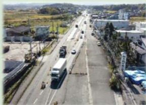
一般国道368号 （伊賀名張拡幅1工区）
