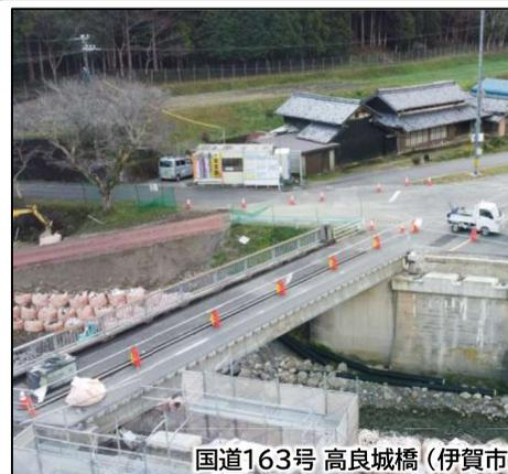
渡河部の橋梁について、豪雨時の洪水や流木の衝撃等による橋の流失を防止するため、橋脚数が多い橋梁を、架け替えにより橋脚数の少ない構造形式に変更する流失防止対策を推進
