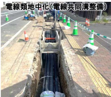
電線類地中化(電線共同溝整備)
