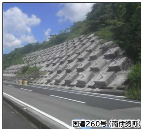
激甚化、頻発化する豪雨や、大規模地震が発生した際に、崖崩れによる道路交通への影響を抑えるため、斜面をコンクリート製の枠などで固定する道路法面対策を推進
