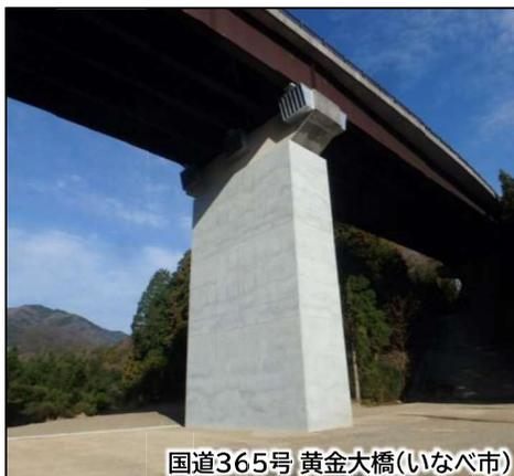
大規模地震が発生した際に、損傷による長期間の通行止めを防ぐため、損傷が限定的なものに留まり速やかに機能回復ができるよう、橋の落橋防止、橋脚補強対策を推進
