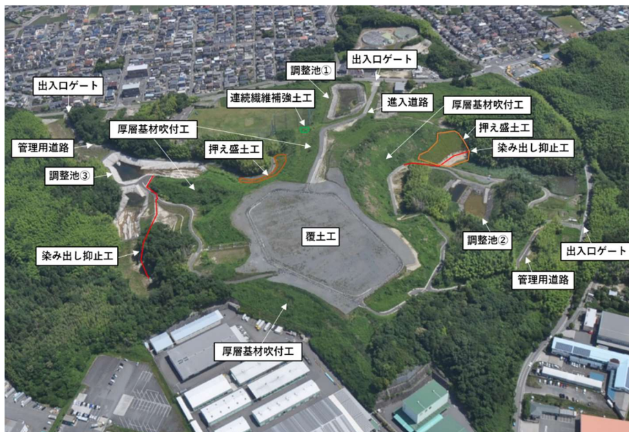
図 支障除去対策工の施工箇所（対策後の事案地）
