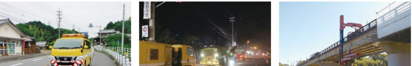
南若松地区海岸・千代崎港原永地区海岸 海岸高潮対策事業
