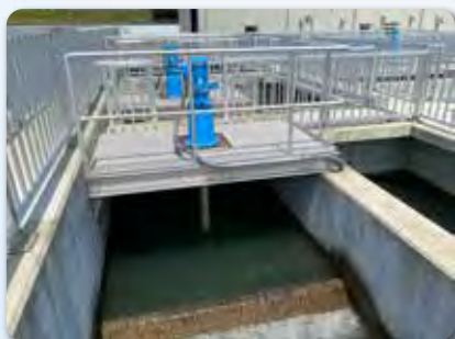
〔急速かくはん池〕
