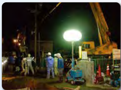
夜間の漏水復旧作業
