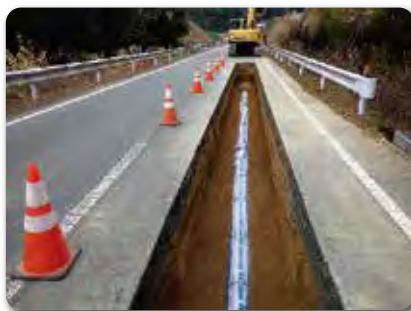
耐震管への布設替え
