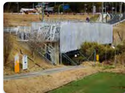
塗装塗替中の水管橋
