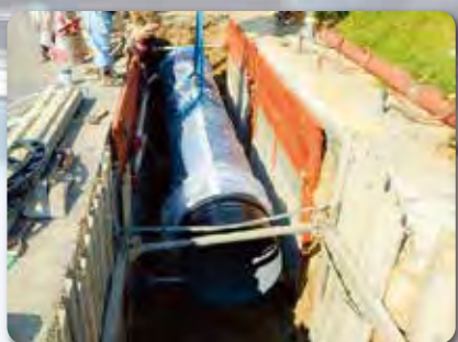
配水管布設替工事の施工状況
