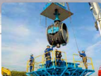
制水弁取替工事の施工状況
