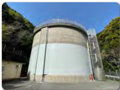
調整池の耐震補強
