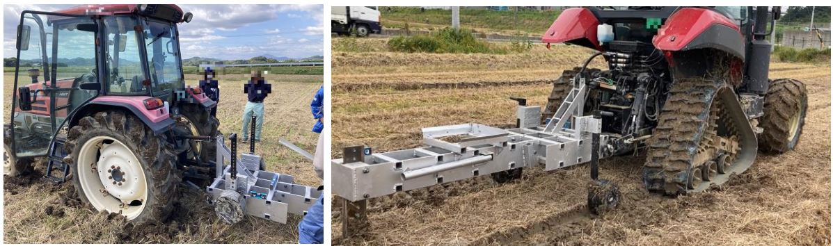
図 17 畦畔が硬く落水口施工時にスリップしたトラクタ(80 馬力級ホイール) (左) 湿潤状態のほ場で本暗渠を施工するトラクタ(105 馬力セミクローラ) (右)
