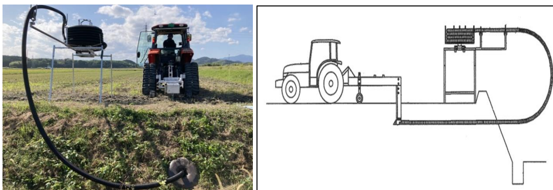
図5 本暗渠施工の様子（左：施工中（後方から）、右：施工中（側面から））
