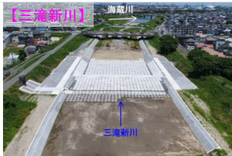
三滝新川の開削工事状況
