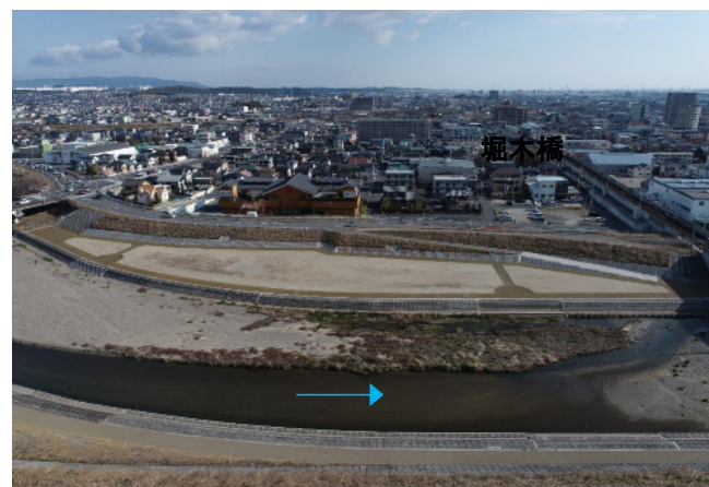
三滝川：堀木橋下流護岸
