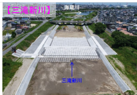
三滝新川の開削工事状況
