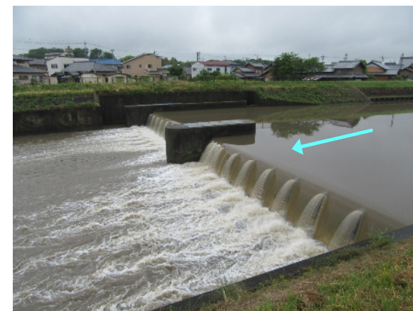
福水井堰（海蔵川5.7k付近）
