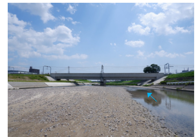
三滝川：近鉄橋梁架替
