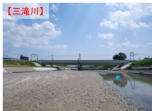
近鉄橋梁架替
