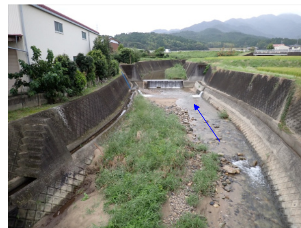
上流端から下流方向
