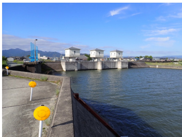
下流端の水門
