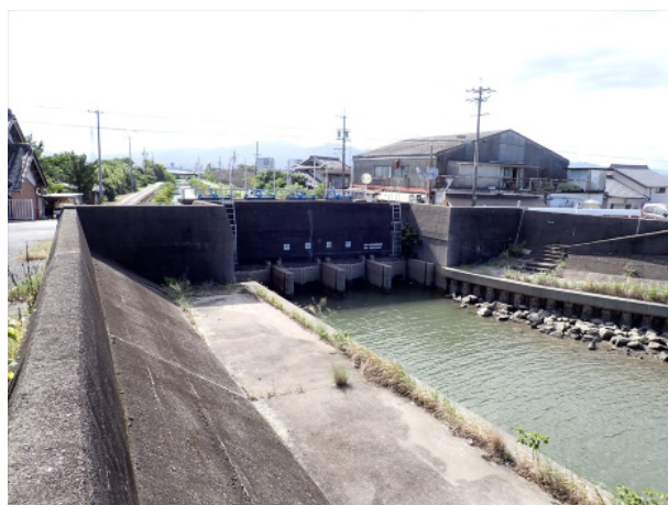
下流端の水門
