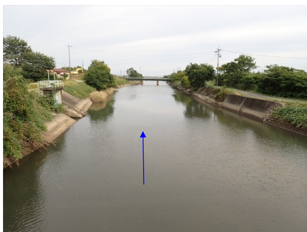
巡見橋から下流方向
