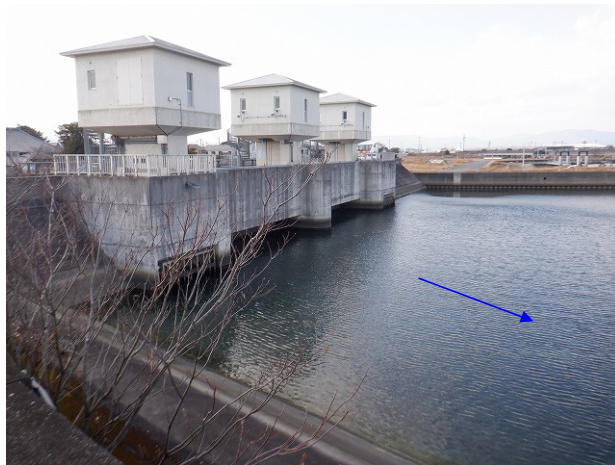
百々川 防潮水門
