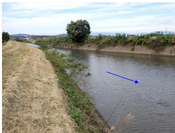
岩内川合流点から上流方向
