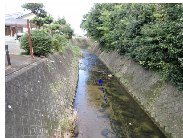
上流端から下流方向
