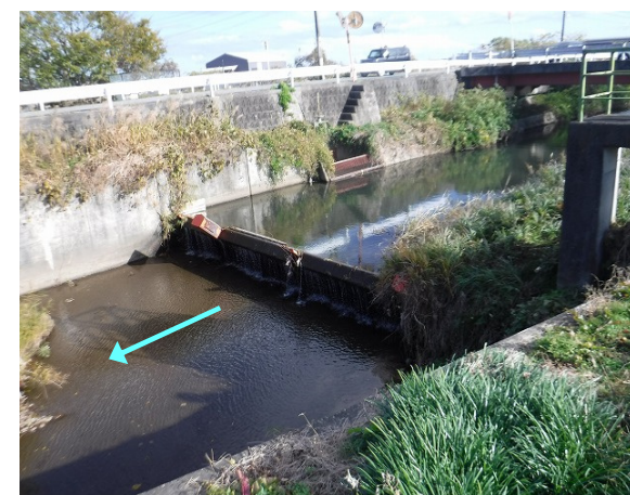
此亦（しまた）統合堰（堀坂川2.3k付近）
