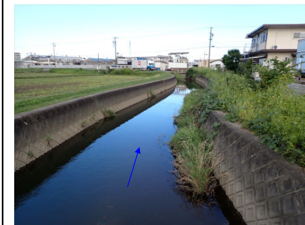
県管理区間上流端から下流方向
