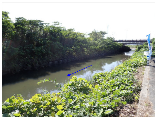
中川橋から上流方向
