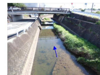
三渡川 三蔵橋下流 (上流部)
