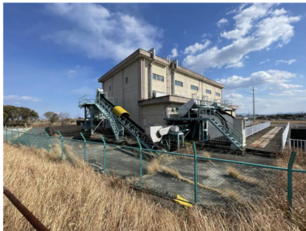
百々川 排水機場
