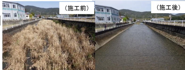
磯部川緊急浚渫推進事業 (三重県)
