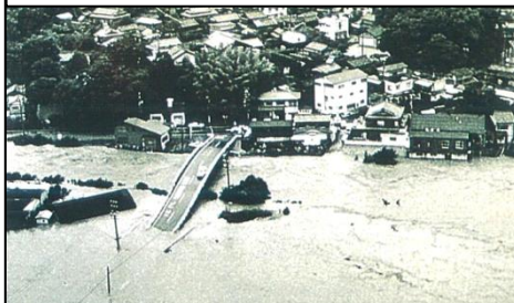
平成27年9月豪雨時浸水状況
