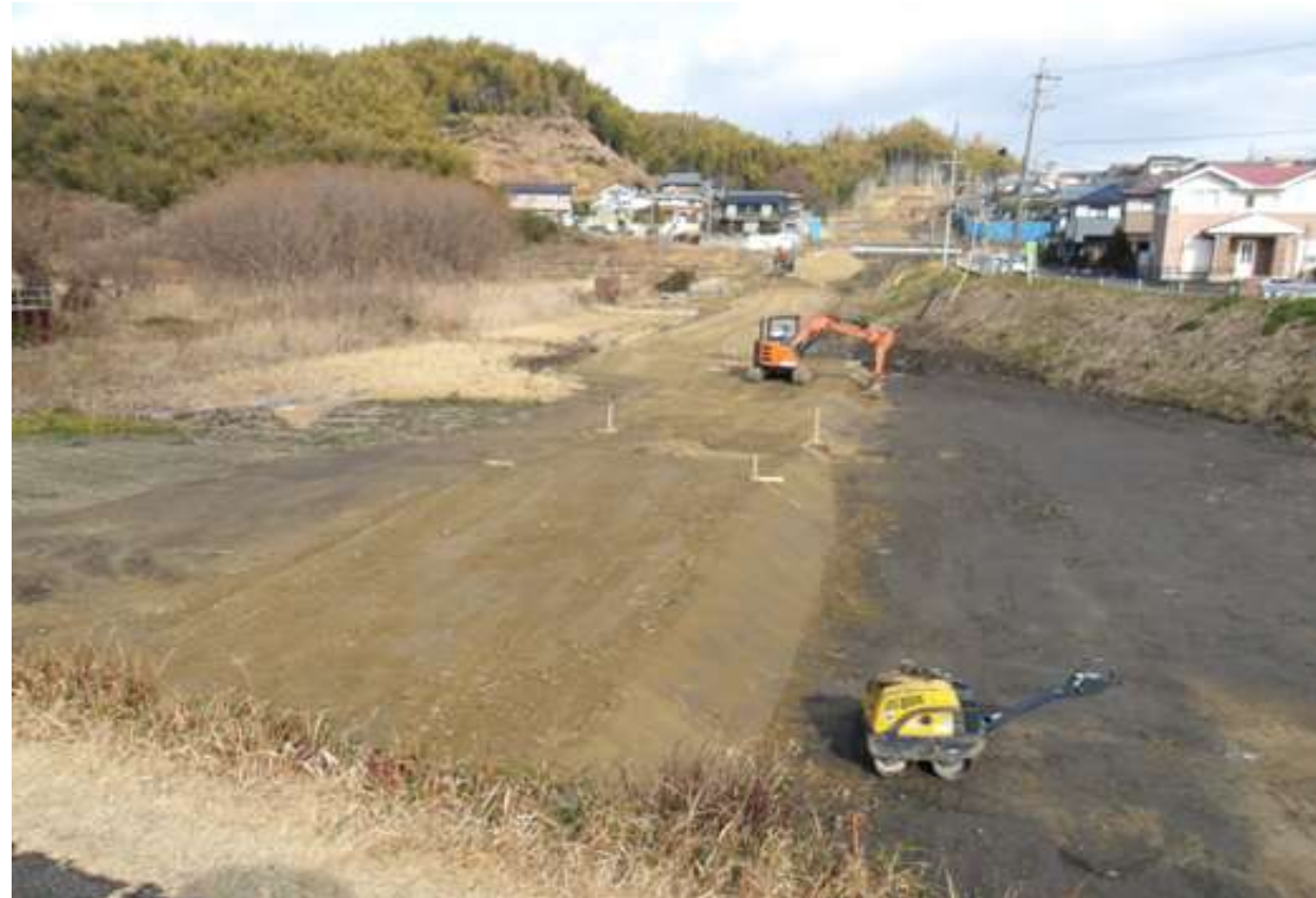
施工中 工事用道路盛土
