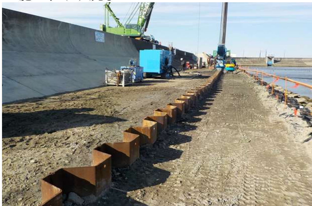
施工中 圧入完了
