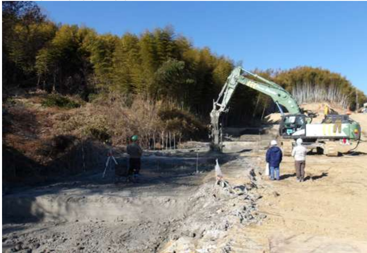
施工中 工事用道路盛土
