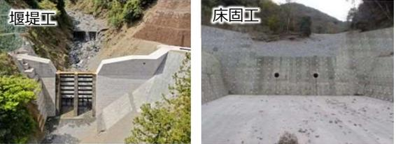
堰堤工 床固工
