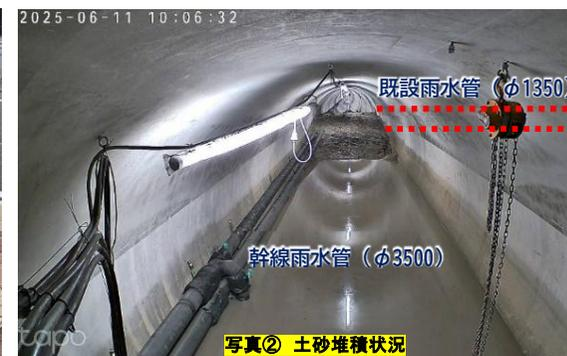
写真② 土砂堆積状況
