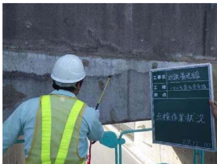
大型カルバート 点検状況
