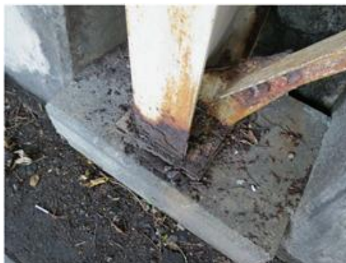
柱の腐食
