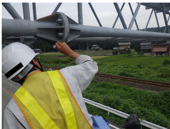
(定期点検状況)
