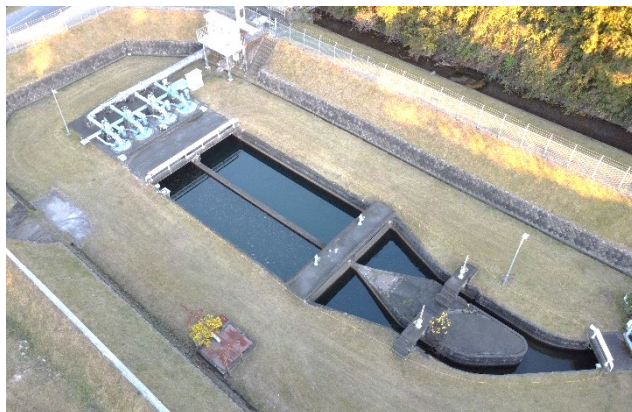
浸水対策予定の高野浄水場取水沈砂池（津市）
