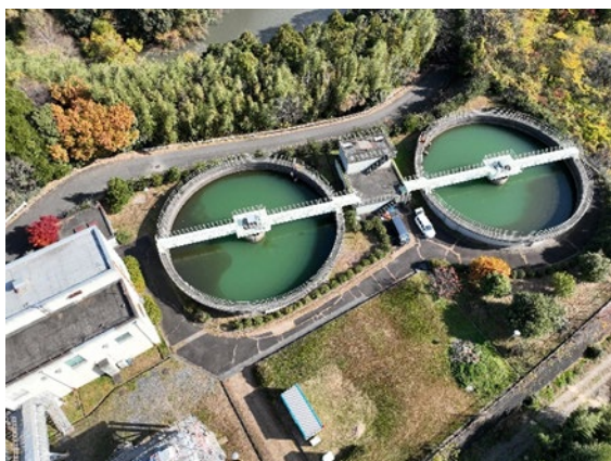
耐震補強工事が完成した伊坂浄水場 排水処理施設※（四日市市）
