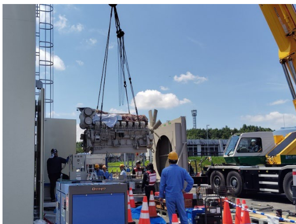
更新工事中の高野浄水場非常用発電設備 （津市）
