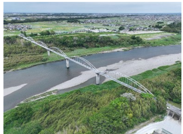
塗り替え予定の宮川水管橋（伊勢市）
