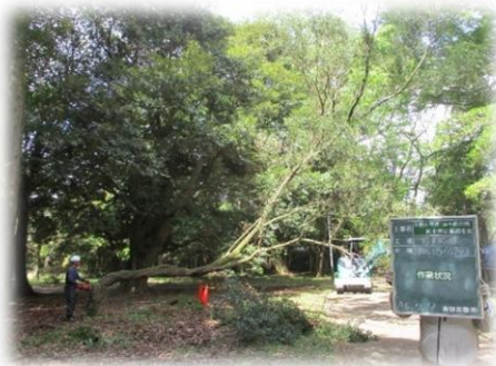
枯損木の伐採状況（五十鈴公園）
