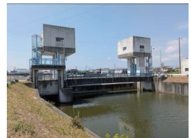
横川防潮水門 ＜津市＞
