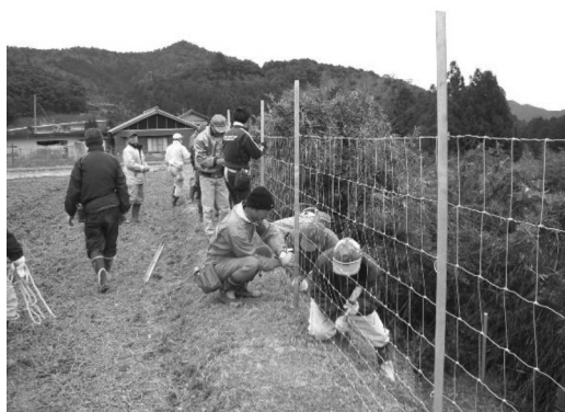
侵入防止柵の設置
