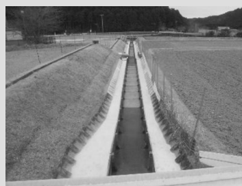
(農業用排水路)
