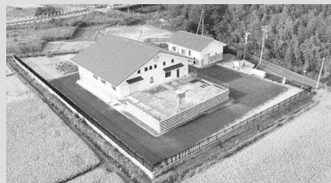
(農業集落排水施設)
