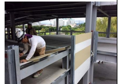
駐車場の角部の施工風景
