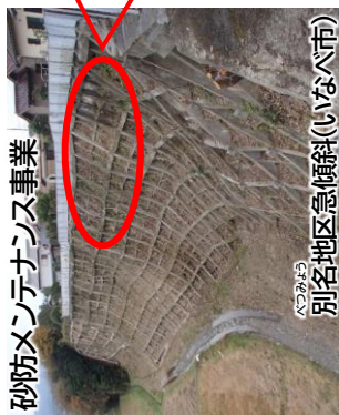
急傾斜の修繕(法格内土砂流出)
