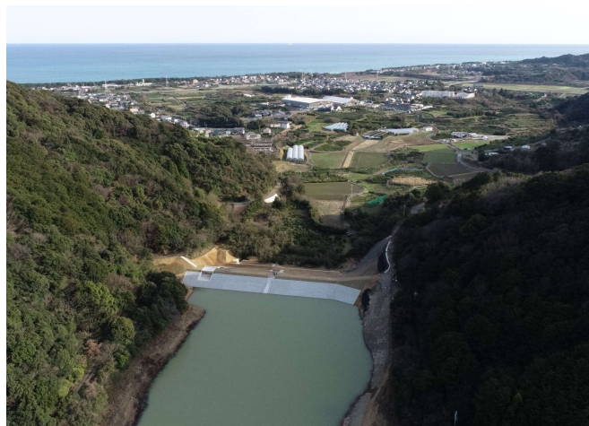
農業用ため池の整備
