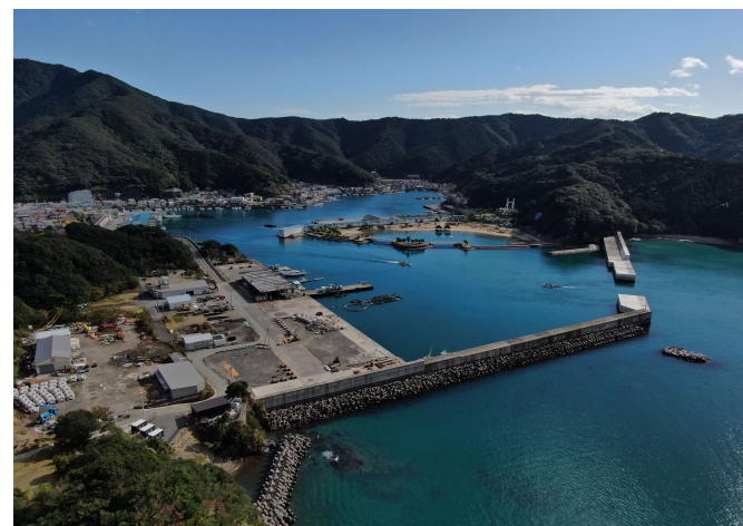
防波堤の整備
