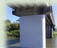
橋梁の落橋・倒壊対策
