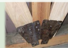
土台・柱部分に設置された補強金物
