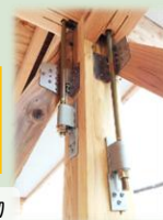
梁・柱部分に設置された補強金物
