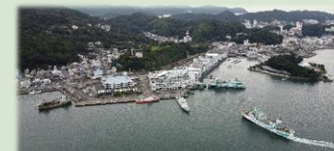
鳥羽港 耐震強化岸壁の改修（鳥羽市）
