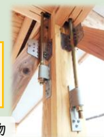
梁・柱部分に設置された補強金物
