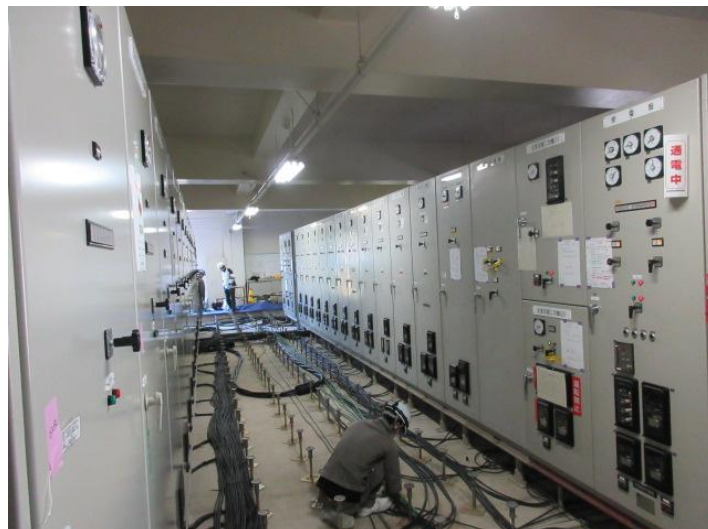
更新中の高野浄水場受変電設備（津市）
