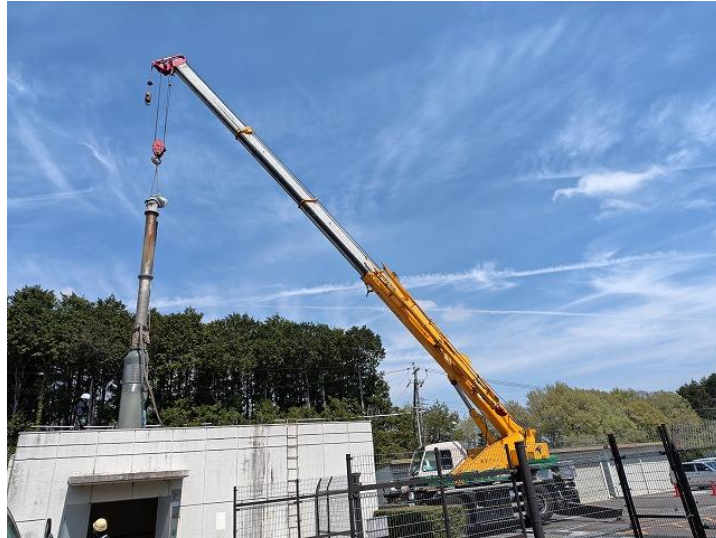
搬出中の高野浄水場送水ポンプ設備（津市）
