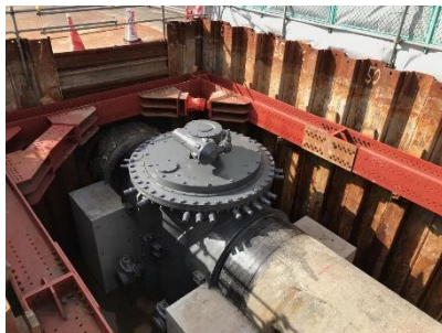
制水弁設置工事の施工例
