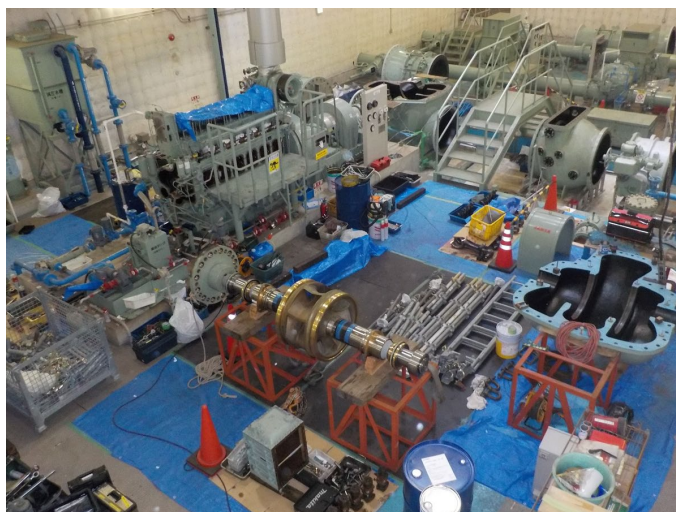
分解点検中の山村ポンプ所 取水ポンプ設備（四日市市）
