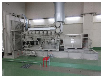
非常用発電設備設置工事の施工例
