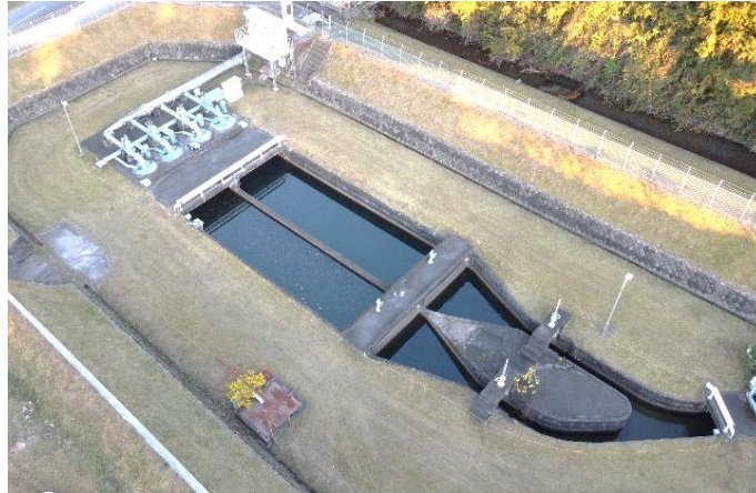
浸水対策工事を実施する高野浄水場取水沈砂池（津市）
