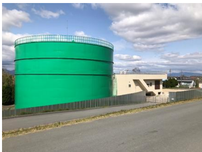
建設予定の配水池（既存）
