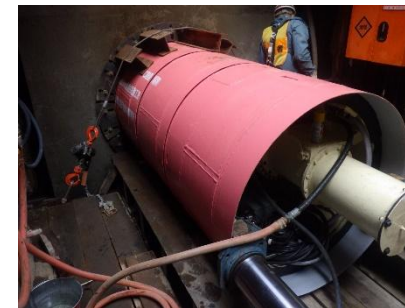
配水管推進工事の施工例
