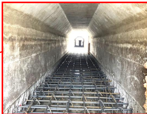
急速ろ過池流入渠 底版増し厚の施工状況
