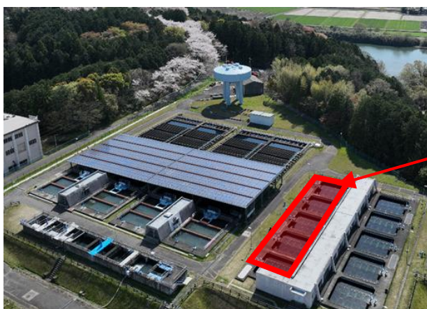
耐震補強工事を実施した高野浄水場（津市）
