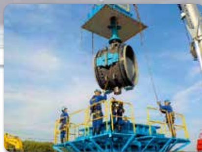
制水弁取替工事の施工状況
