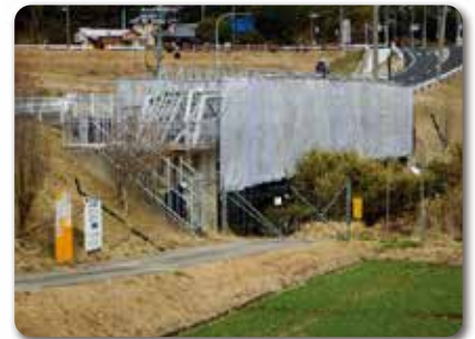
塗装塗替中の水管橋
