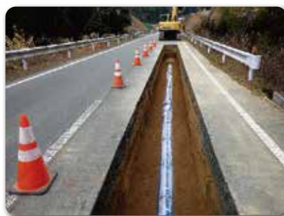
耐震管への布設替え
