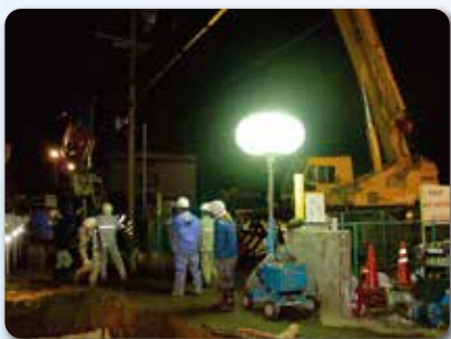
夜間の漏水復旧作業
