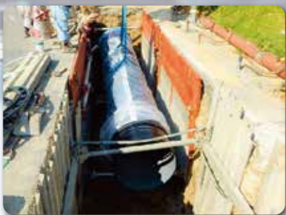
配水管布設替工事の施工状況
