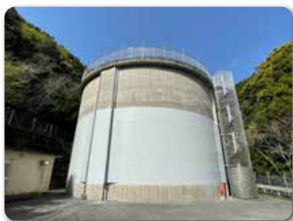
調整池の耐震補強
