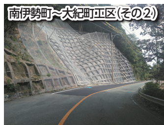
⑱国道 260号(大紀町)
