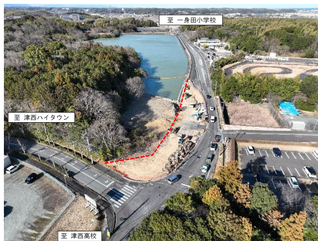
県道 久居河芸線（新池）
