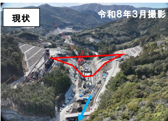
【鳥羽河内川】 鳥羽河内ダム (鳥羽市河内町)
