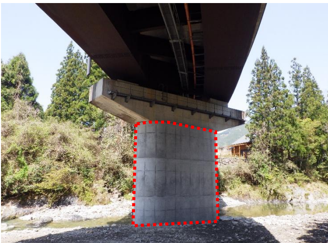
国道 166 号（乙栗子口橋）
