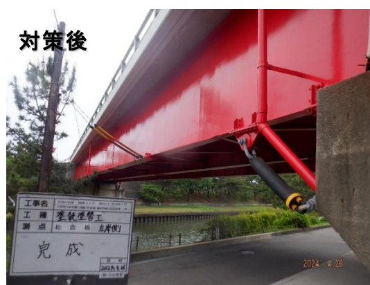
塗装塗替、地覆修復
