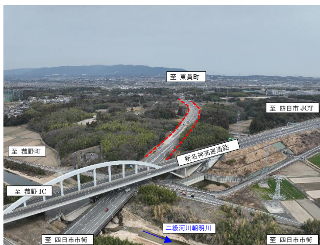
国道 365 号（小牧拡幅）
