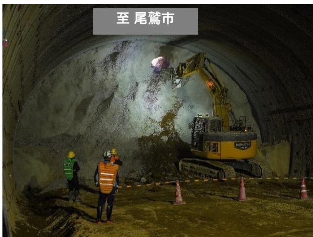
熊野道路（熊野第二トンネル（仮称））
