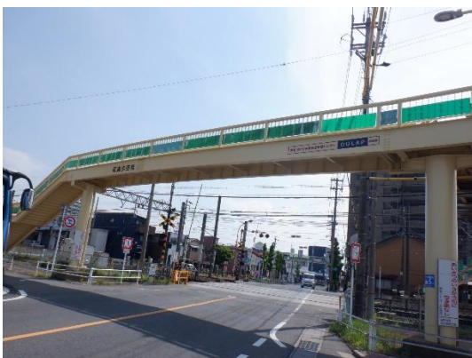
うまみち 馬道横断歩道橋 「桑名 おくやみ手続き支援センター OULAP歩道橋」 (桑名市)
