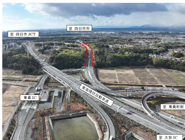
国道 365 号（東員工区その1）
