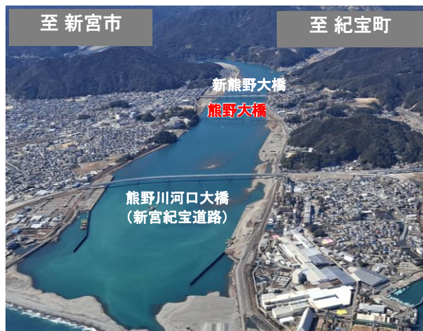
熊野大橋更新 （熊野大橋撤去・新熊野大橋自歩道整備）
