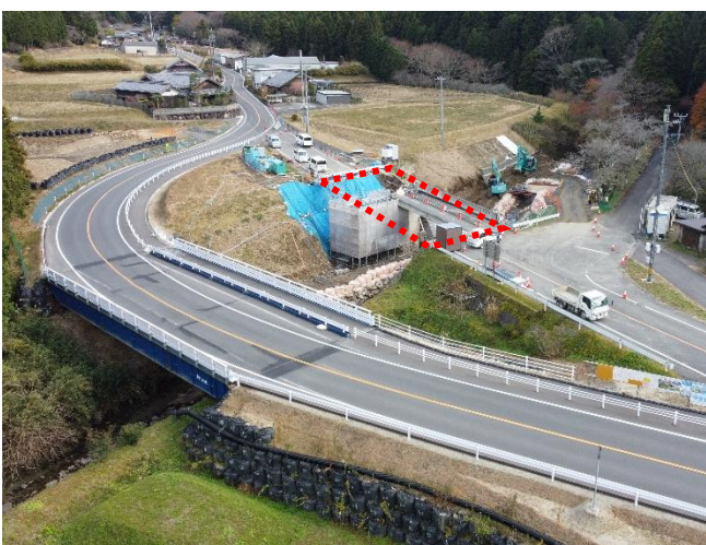
国道 163 号（高良城橋）
