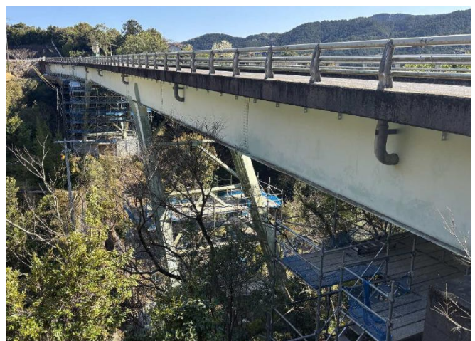
国道 311 号（西の谷橋）
