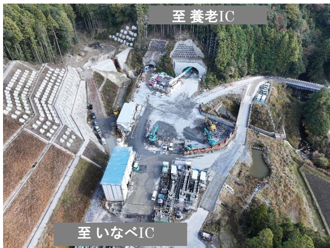
東海環状自動車道（県境トンネル）
