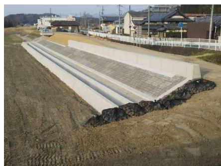
受賞した現場（完成写真）
