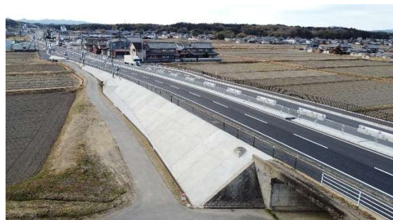
受賞した現場（完成写真）
