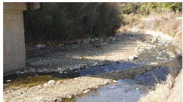
受賞した現場（完成写真）
