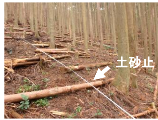
伐倒木を利用した土砂止の設置
