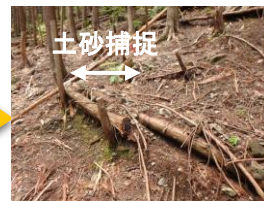
土砂止の土砂捕捉量などの多点調査
