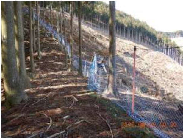
獣害防護柵設置の様子（津市）
