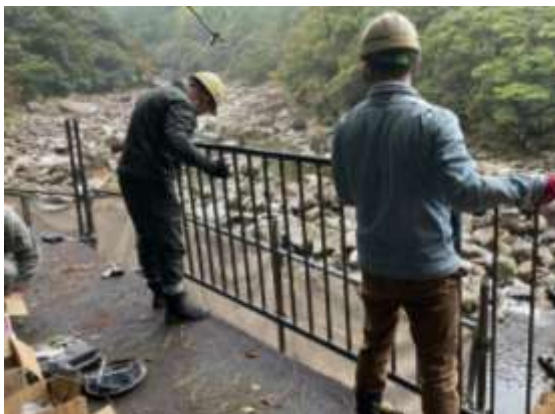
森林教育フィールドの整備(施工状況)
