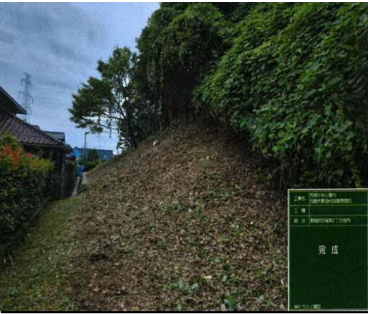
写真6 施工後（笹尾中央公園）
