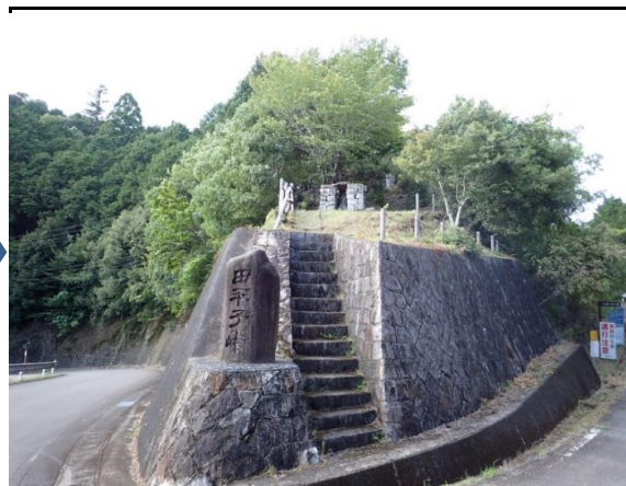
写真4 下刈り（田平子公園・実施後）
