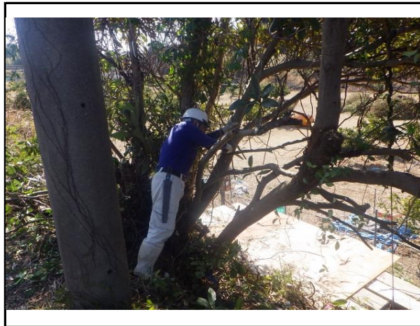
写真2 町道山路線支障木伐採工事（実施中）
