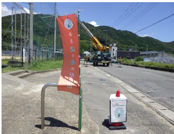
写真5 支障木伐採（有馬中学校・実施中）
