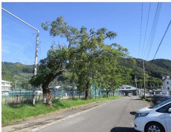
写真3 支障木伐採（有馬中学校・実施前）
