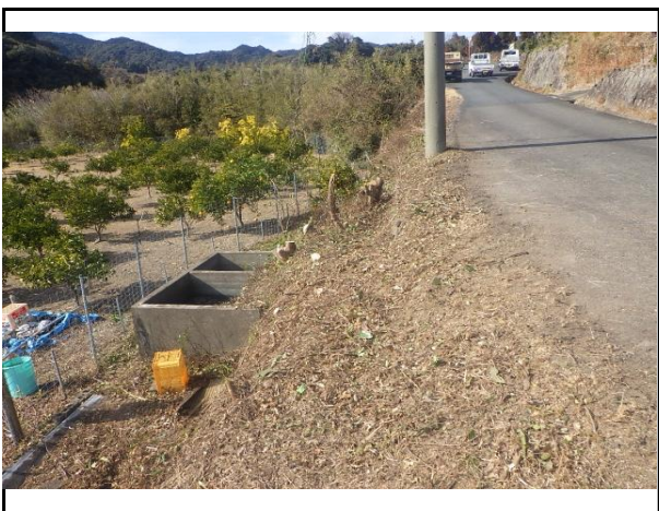
写真3 町道山路線支障木伐採工事（実施後）
