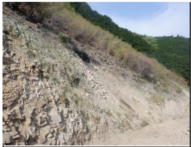
写真4 R7環境整備後、別事業での法面への種子吹付により緑化を行った
