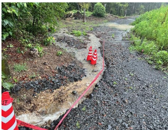
写真5 園地進入路整備（防災公園クマノザクラ園地・実施前）
