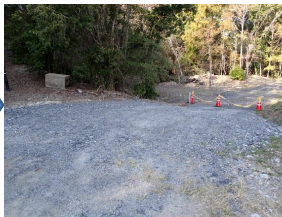
写真6 園地進入路整備（防災公園クマノザクラ園地・実施後）
