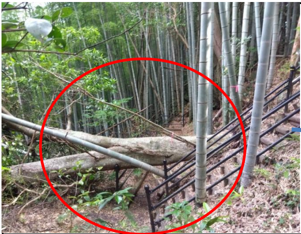
写真1 五ヶ所浦 実施前
