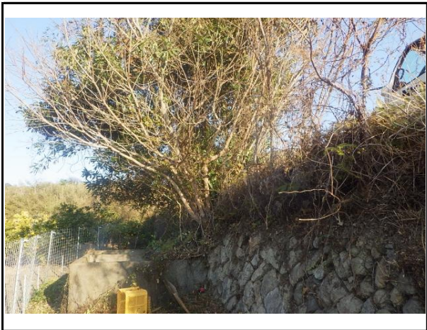
写真1 町道山路線支障木伐採工事（実施前）
