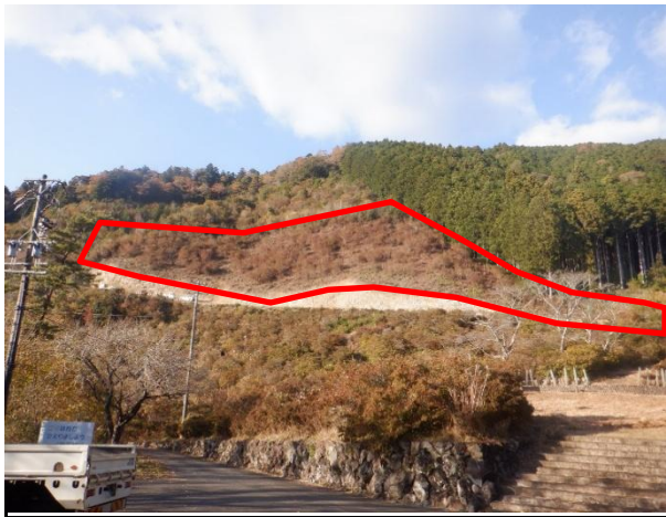
写真1 環境整備作業中遠景 （人力による雑木除去集積搬出）
