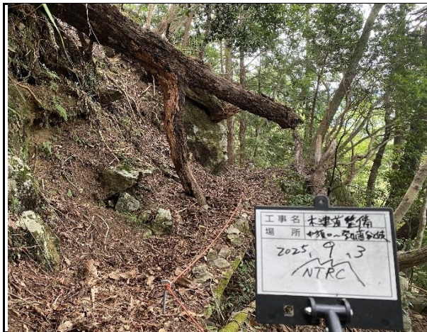
写真1 令和7年度実施 NTRC 木津道 風倒木処理前
