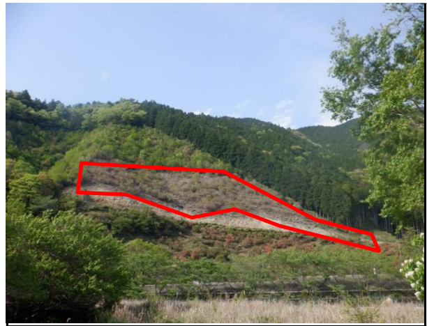
写真2 R6年度に整備した道路を活用し環境整備を行いつつじ以外の雑木等を除去を行った。
