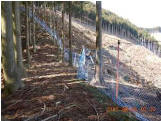
獣害防護柵設置の様子（津市）
