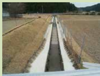
(農業用排水路)
