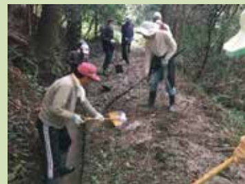
(水路の泥上げ)
