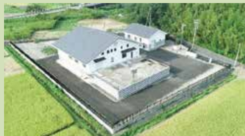
(農業集落排水施設)
