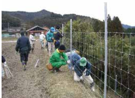
侵入防止柵の設置
