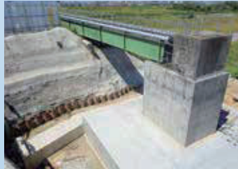
水管橋の耐震化
