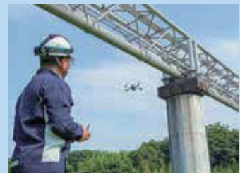
ドローンによる点検
