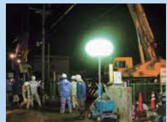
夜間の漏水復旧作業
