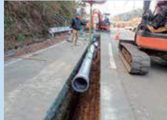
耐震管への更新
