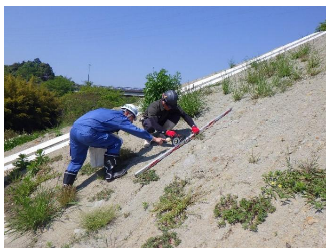
盛土構造の確認状況
